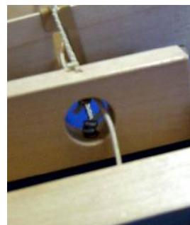
**Верхний карниз.** В верхнем карнизе необходимо изготовить отверстия Ø 18 мм под установку суппортов с роликами.
